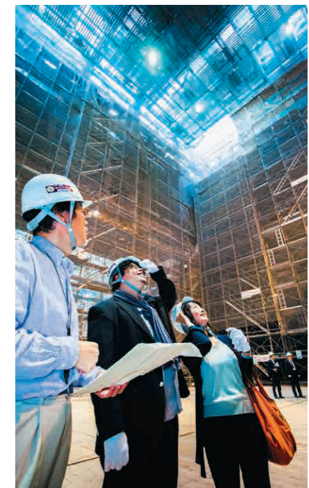
劇場の建設現場を視察。ステージを興味深く見上げる。
