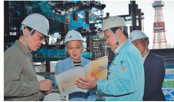
建設中の現場視察に訪れた尾高さん。劇場の設備と進行状況について興味深く聞き入る。
